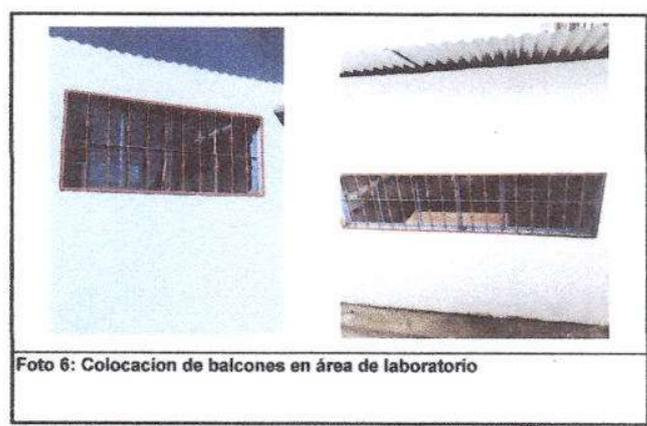
Foto 6: Colocacion de balcones en área de laboratorio
