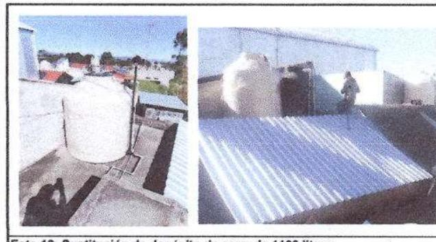
Foto 12: Sustitución de depósito de agua de 1100 litros
